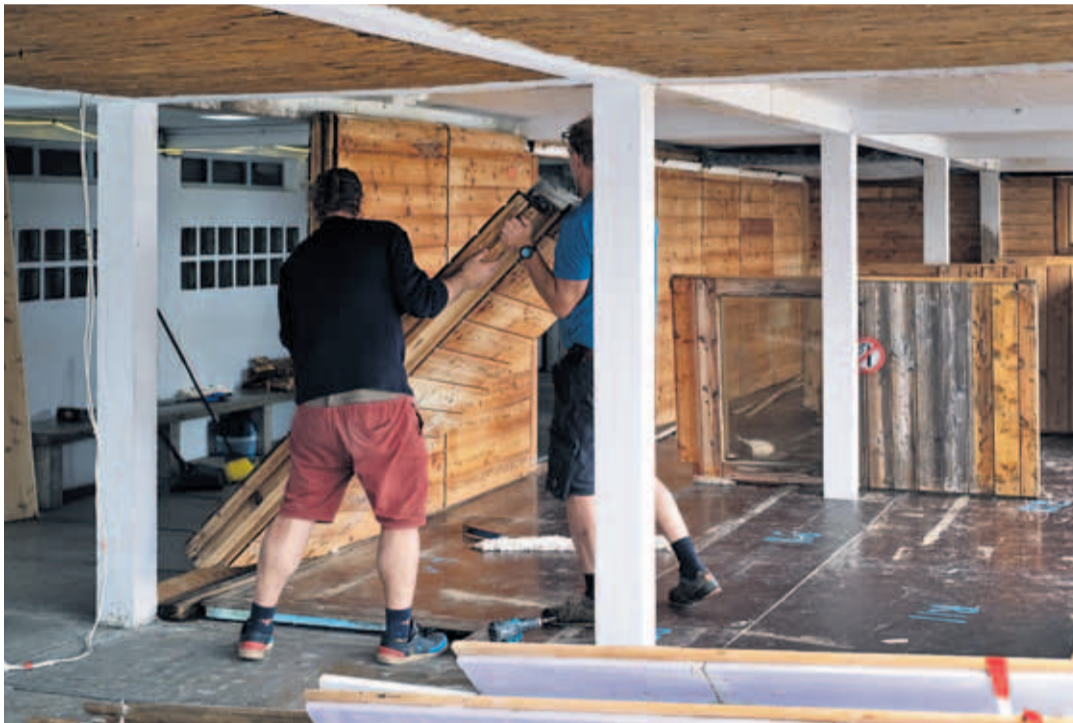
Démontage du sauna et de la salle de repos.
