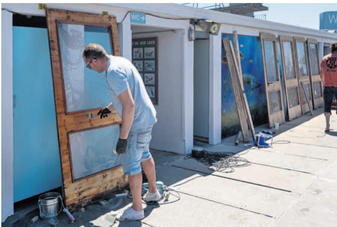
Entretien et réfection des éléments de la cabane de la Buvette avant leur stockage.
