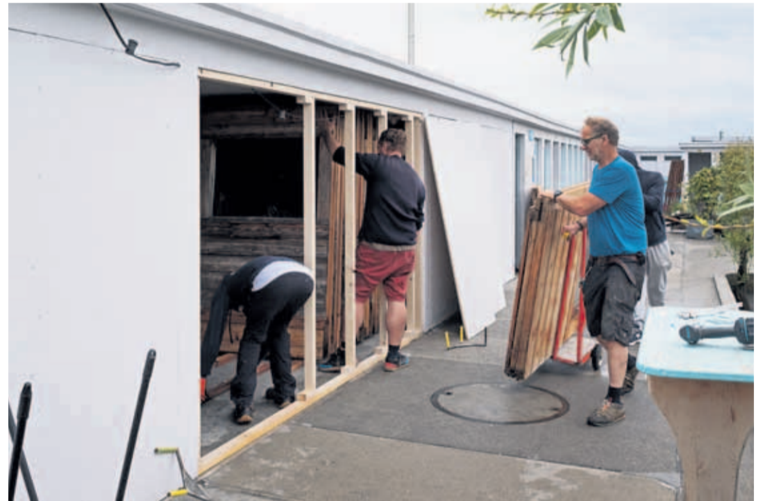
Stockage des éléments du sauna et de la salle de repos.
