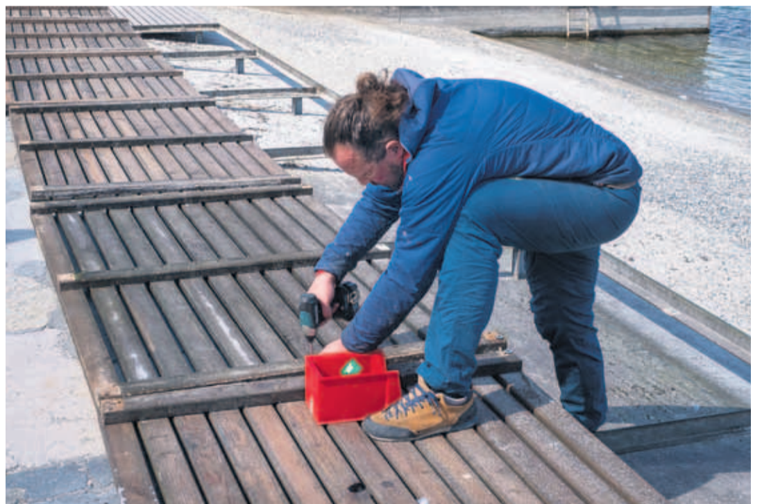
Contrôle et réparation, si nécessaire, de 320 claies.
