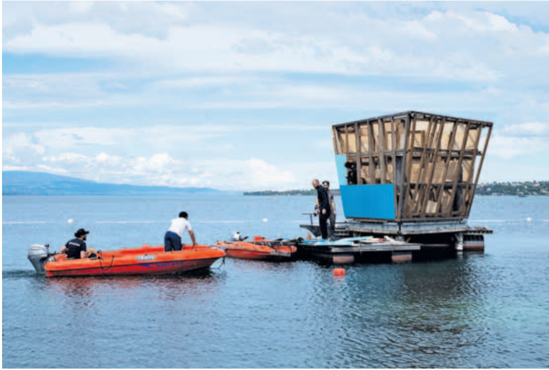
Remontage du mur d'escalade.
