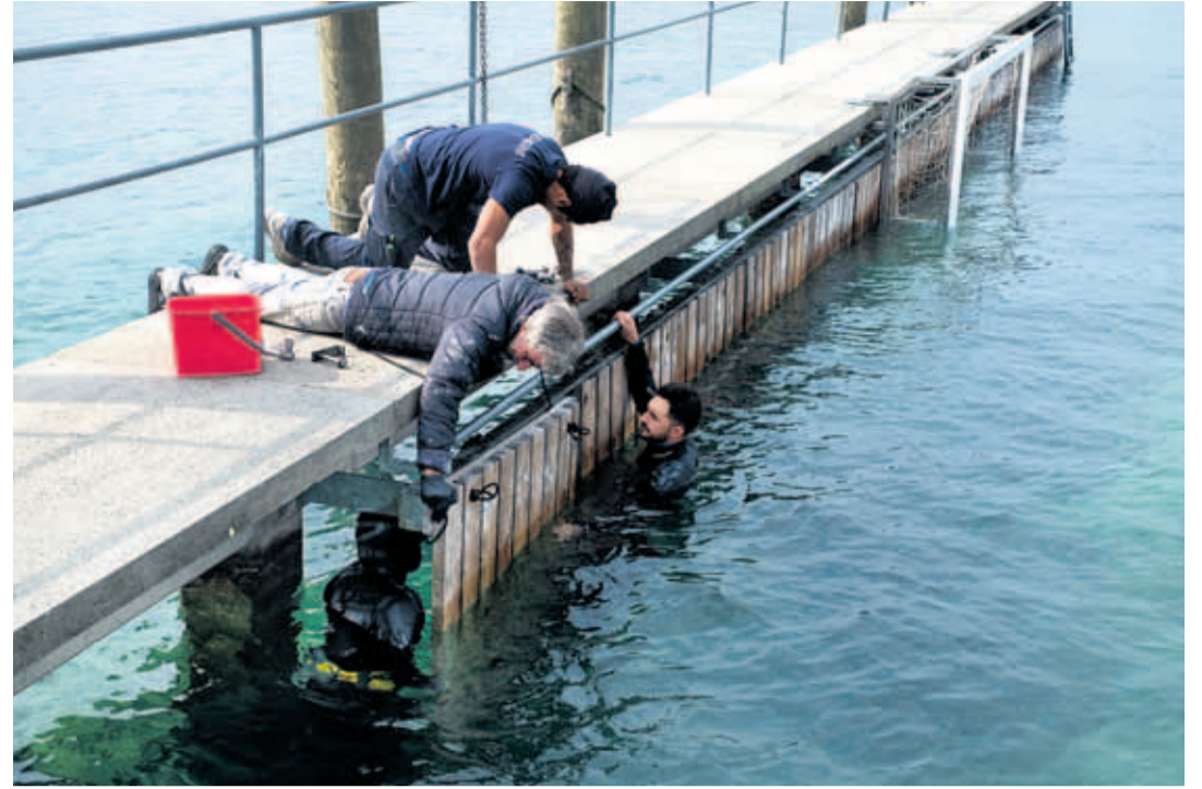
Démontage de 14 palplanches pour les rénover et entretien des 50 autres dans l'eau.
