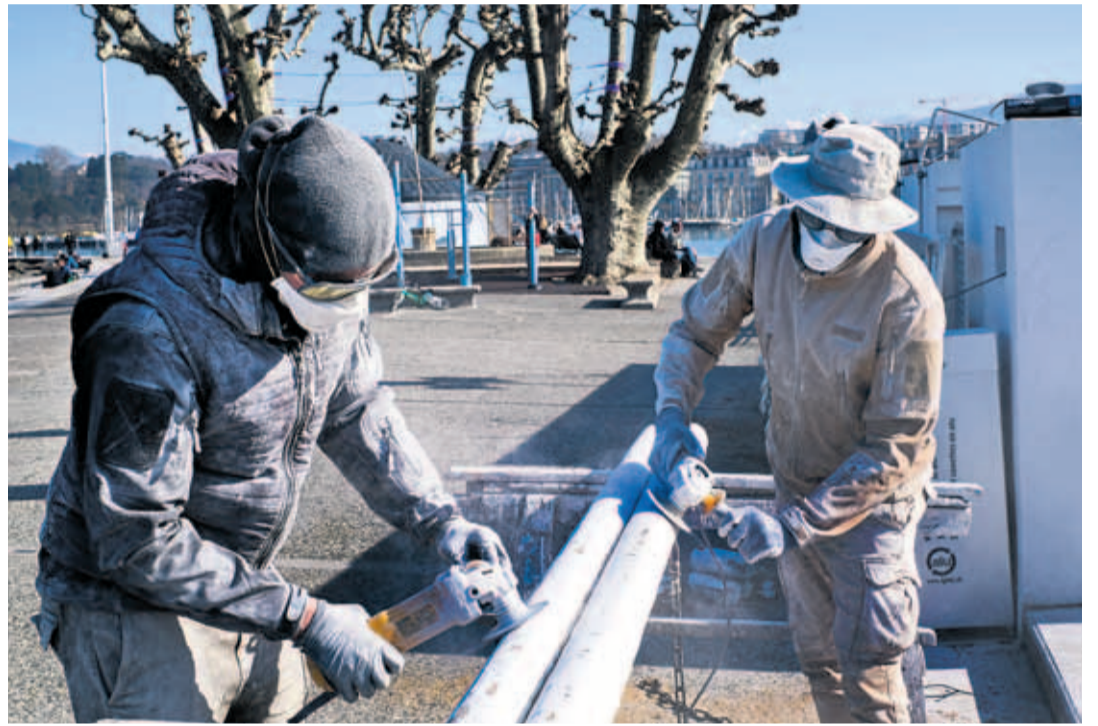
Ponçage et peinture de 80 balises en bois.
