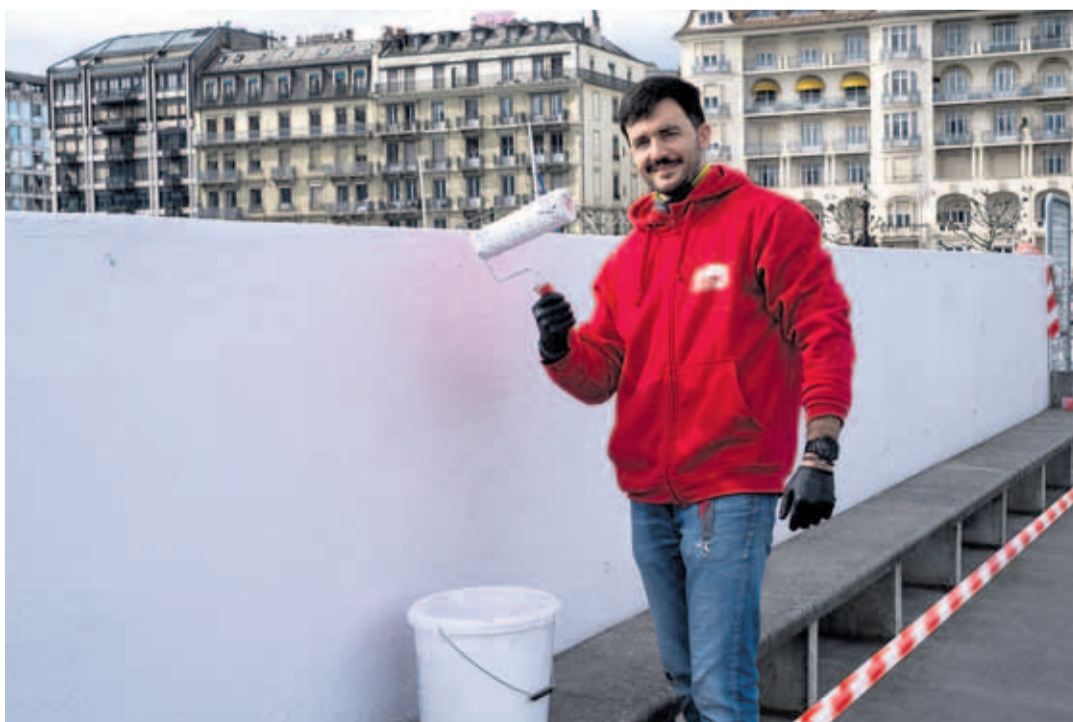
Peinture de 2000 m 2 de murs.
